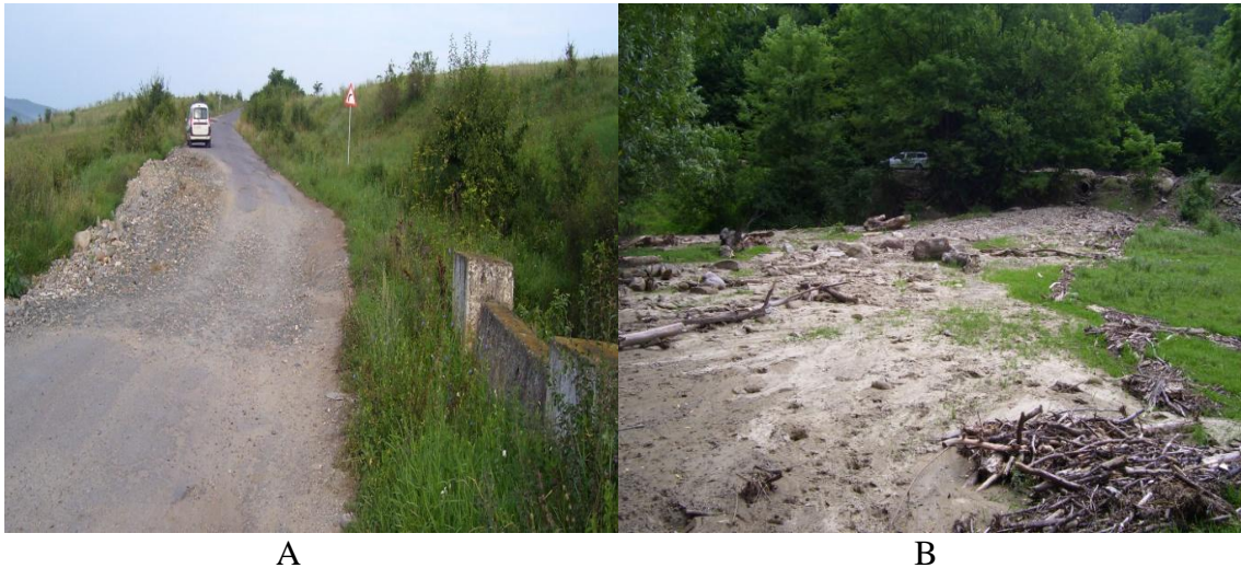
Foto.2. A. Efectele incapacității podețului tubular de a face față volumului de apă scurs prin ravenă (la vest de localitatea Borșa, jud. Cluj). B. Material transportat în timpul viiturii torențiale peste drumul județean 109 E (între localitățile Chizeni și Fodora)
